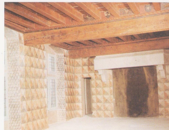
La salle d'apparat haute de Guillaume de Piolenc 1450
